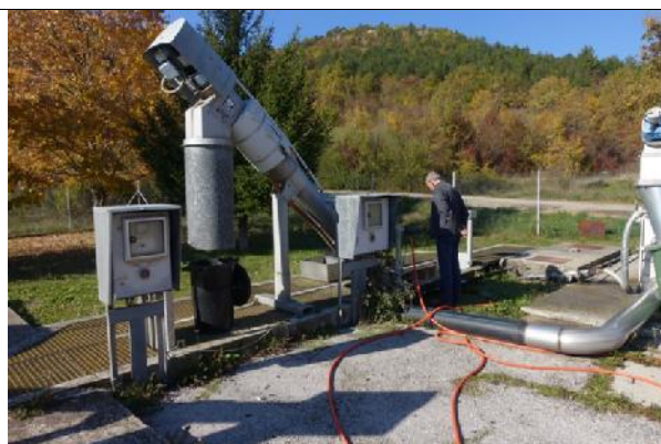
Grafički prikaz B-4: Fina rešetka sa obilaznim kanalom
