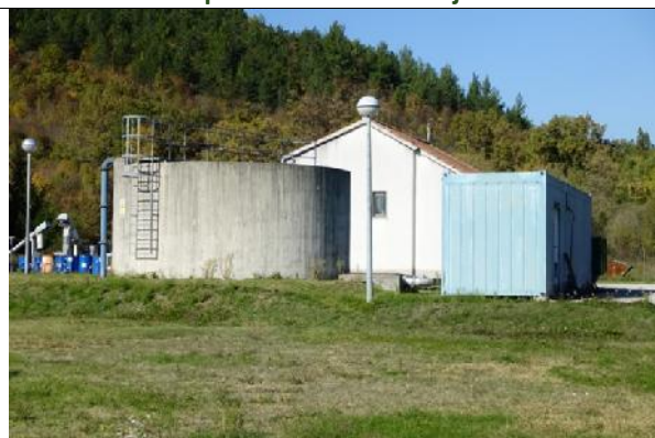
Grafički prikaz B-9: Ugušivač mulja
