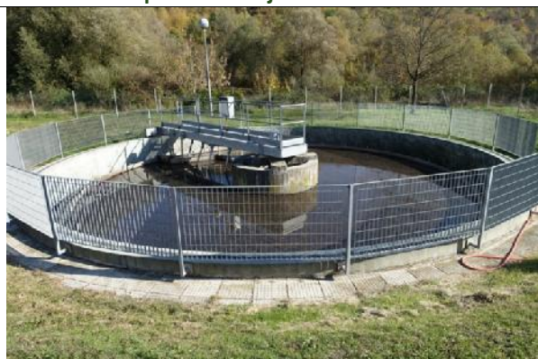
Grafički prikaz B-8: Sekundarna taložnica
